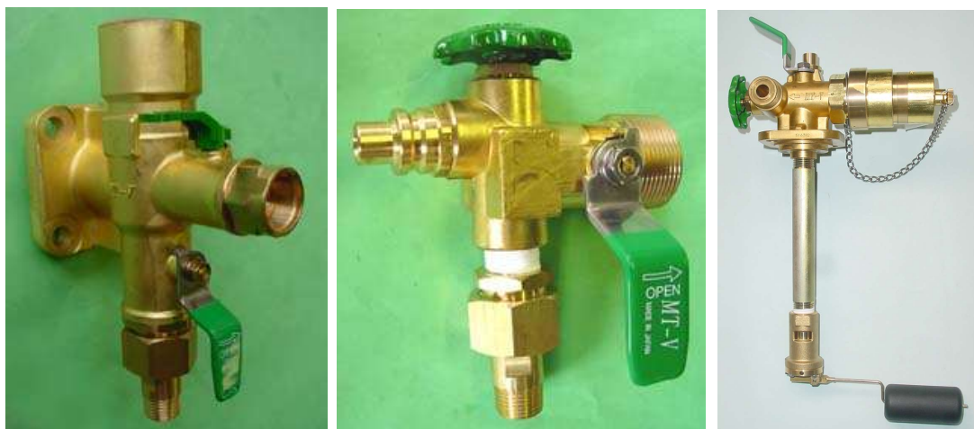
(7) 液取出弁（告示基準 第7条関係の附属機器）
