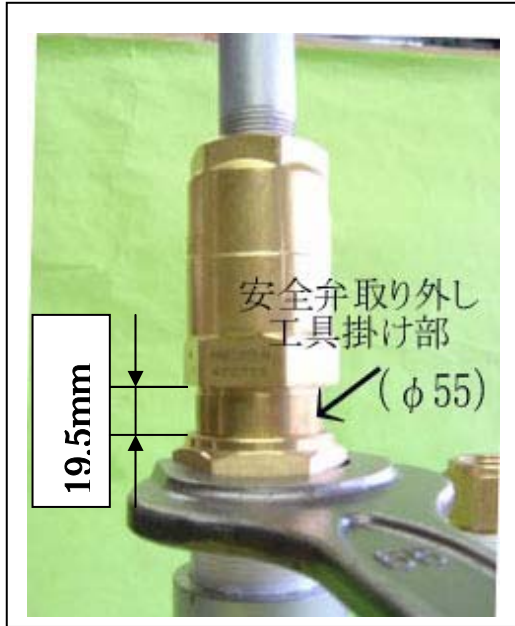
B: 平成 14 年～16 年の安全弁（安全弁工具掛け部は φ55） （エイシン製アルミパイプレンチ EC-510 相当品） （トップ工業製フィルターレンチ TW-230 相当品）
