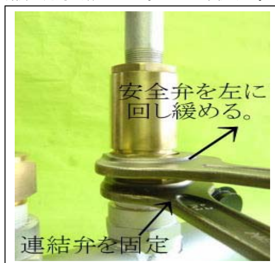
A: 平成14年以前の安全弁（安全弁スパナ掛け部は六角）
